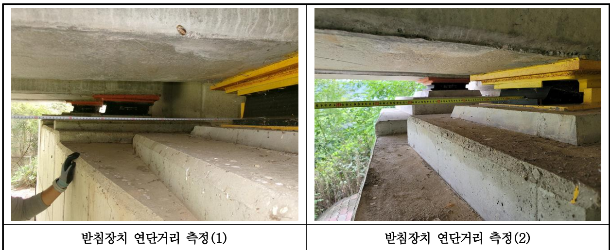
【사진 16.3.15】 교량받침장치 연단거리측정
