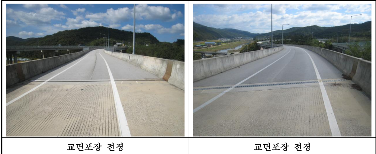
【사진 16.3.20】 교면포장 전경
