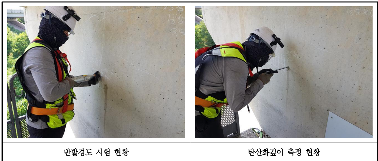
【사진 16.4.1】 콘크리트 내구성조사 현황
