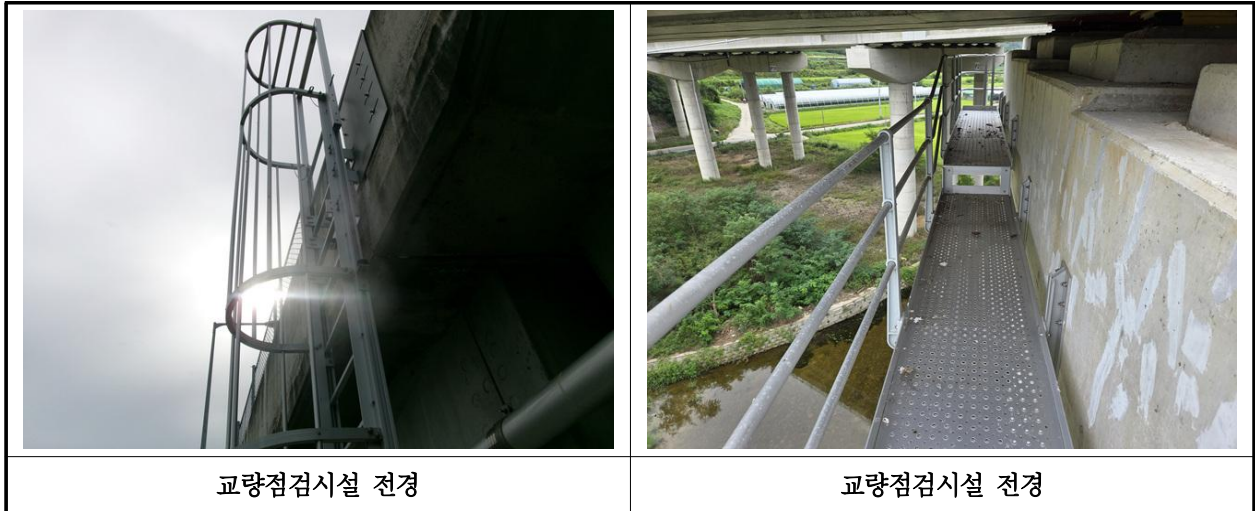
【사진 16.3.26】 교량 점검시설 전경
