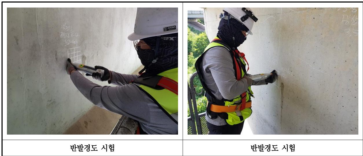
【사진 16.4.2】 반발경도시험 현장사진
