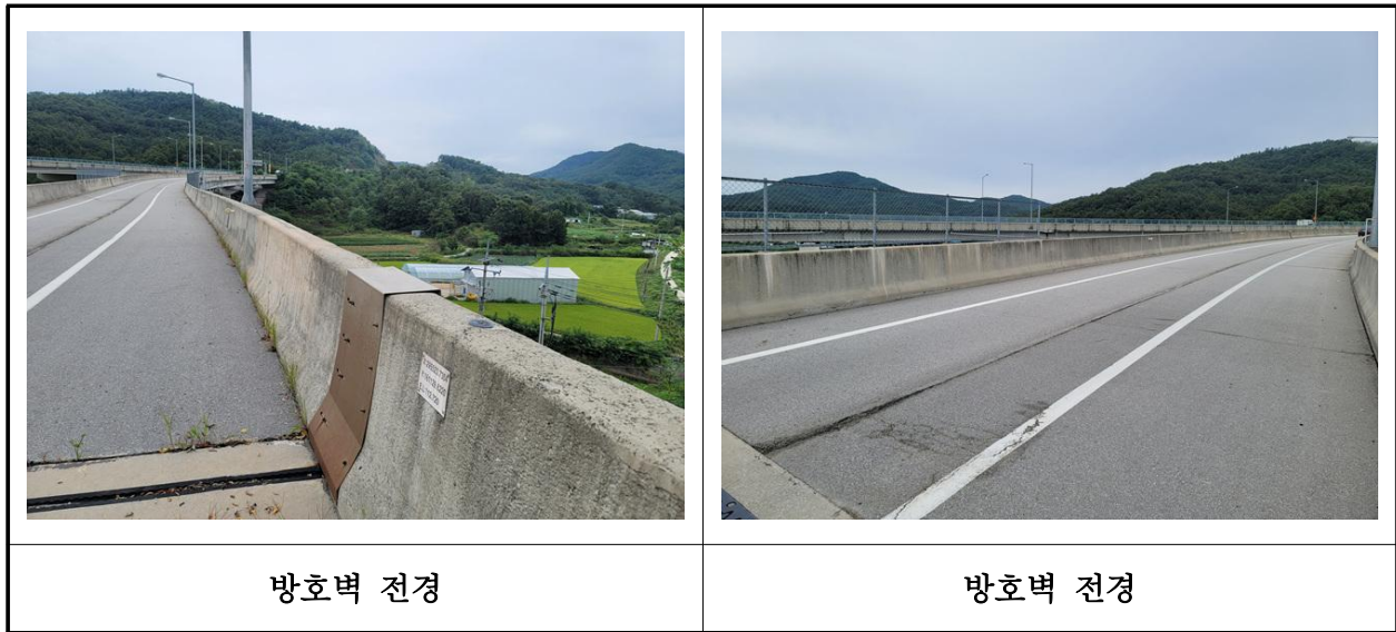
【사진 16.3.24】 방호벽 및 중앙분리대 전경
