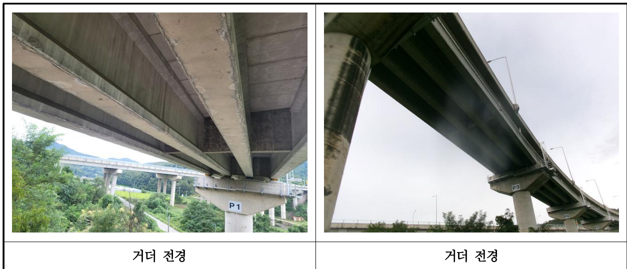
【사진 16.3.4】 거더 전경
