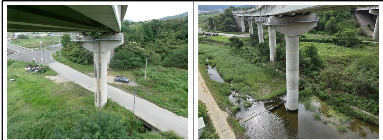
교각 코핑부 상태양호
