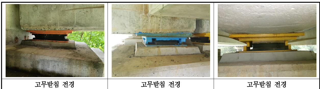
【사진 16.3.13】 교량받침 전경
